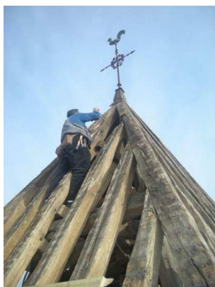
Clocher de l'Eglise pendant les travaux
